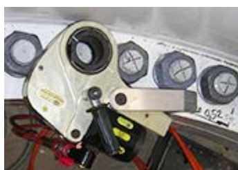
風力発電の大型ボルト締め。特殊反力受けの装着。
