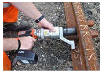
線路の枕木ボルト締め
