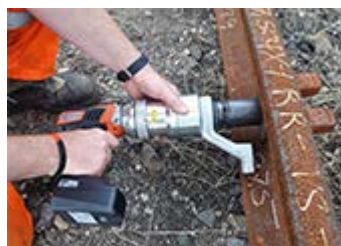
線路の枕木ボルト締め
