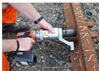
線路の枕木ボルト締め
