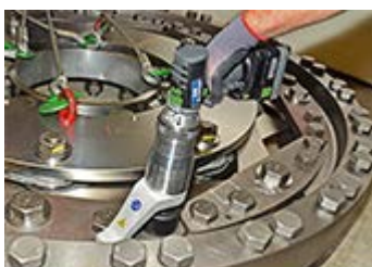
大型フランジボルト締め
