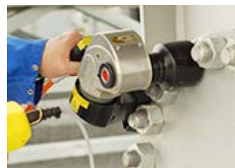
大型フランジボルト締め・緩め
