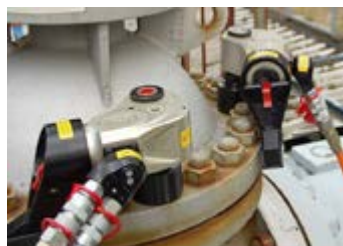
油圧レンチ2台で同時並行締め
