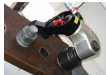
ボルトの締め付け時。反力受けを隣のボルトに当てて使用。
